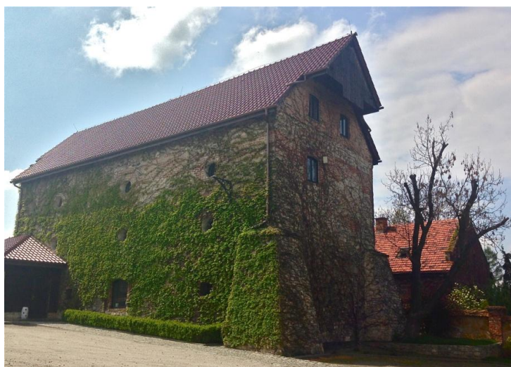
Rys. 10. Restauracja w starym spichlerzu przy ul. Wiejskiej w Gliwicach – kolejny przykład dobrego dobrania nowej funkcji spichlerza do warunków panujących w sąsiedztwie. Źródło: www.trattoriacastello.pl
