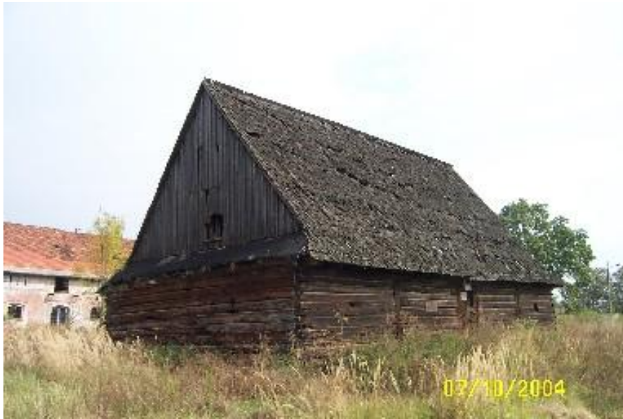
Rys. 5. Zdjęcie spichlerza w Rachowicach z roku 2004, kiedy rozpoczęto prace mające na celu poprawę stanu technicznego spichlerza. Można zauważyć usunięcie roślinności oraz poprawione ściany szczytowe. Źródło: http://jaktrafic.org/ , autor: Piotr Słanina
