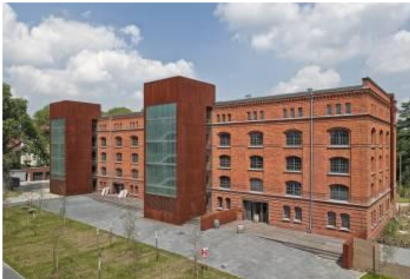
Rys. 9. Lofty wykonane w budynku starego spichlerza w Gliwicach, będące przykładem dobrego wykorzystania spichlerza. Źródło: http://lofty.gliwice.pl/
